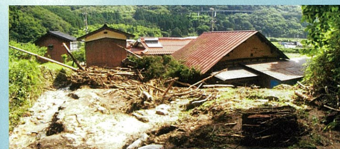
記録的集中豪雨（平成25年7月）による家屋損傷（江府町）
