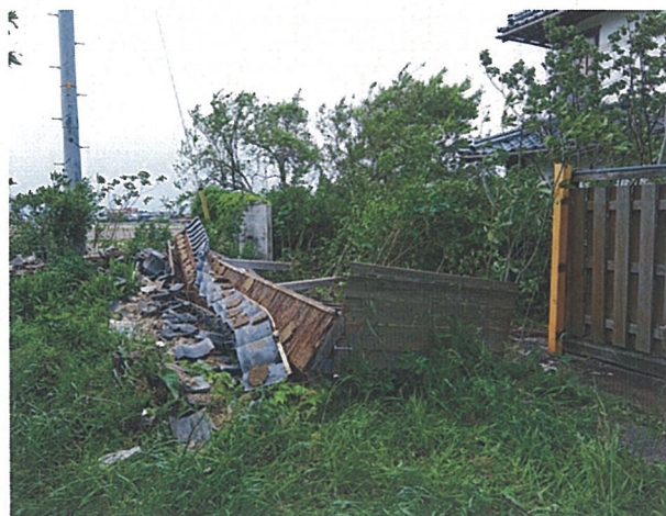
門脇家住宅 倒壊した南塀
