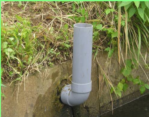
立ち上げ管の設置(付着防止)
