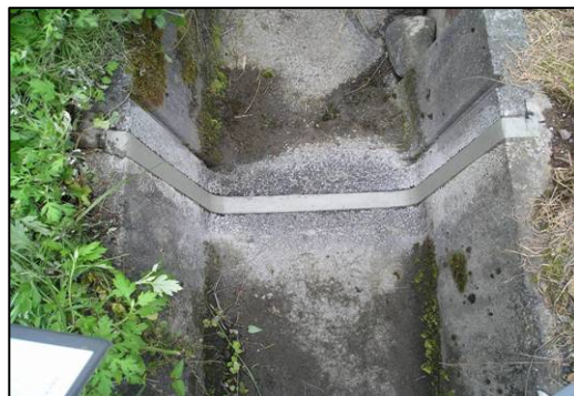
4. テープを剥がして完成！
