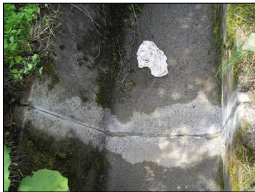
1. 悪くなった目地を剥がし、清掃、目地を乾かす
