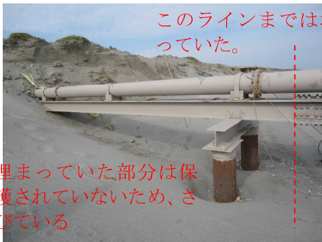
(写真1 3) 配管露出状況
