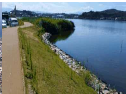
【なぎさ護岸整備】
