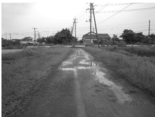
(注) 現状の鷲峰気高線特殊改良一種工事用地
