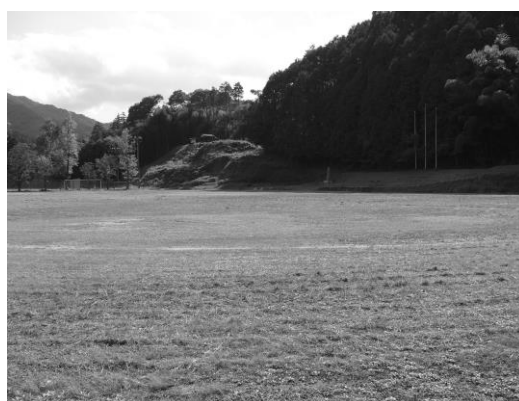
（注）グラウンドの右奥側が法面
