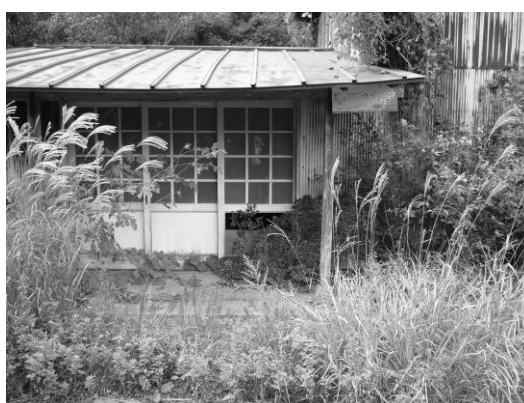
(注) 未利用となっている生徒宿泊所
