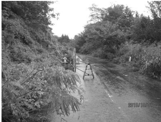
(注) 河内槇原線緊急地方道路整備 工事用地（安蔵側）
