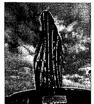
高さ100mの木造タワー
