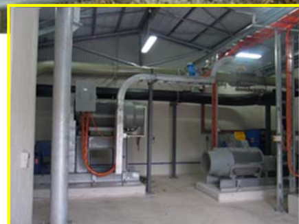
■ ポンプ室内部 (海水くみ上げ用280kw、圧送用280kw)⇒
