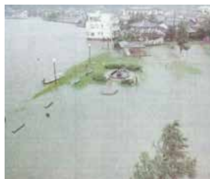
平成23年9月(台風12号災害) 湯梨浜町(東郷池)
