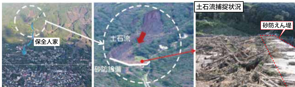
砂防えん堤により、土砂を捕捉し、下流地区の被害を防止した事例(国土交通省HPより)
