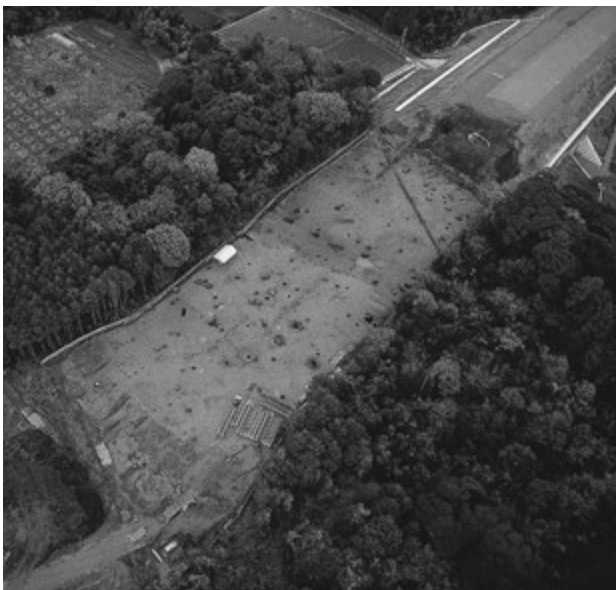
3 調査地全景(調査後、南から)
