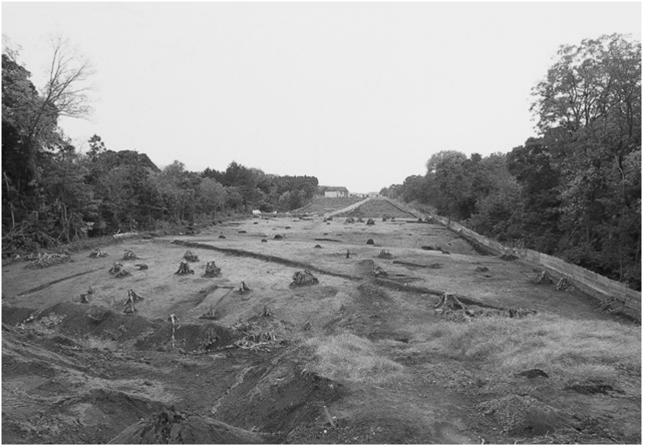
1 調査地完掘状況(北東から)
