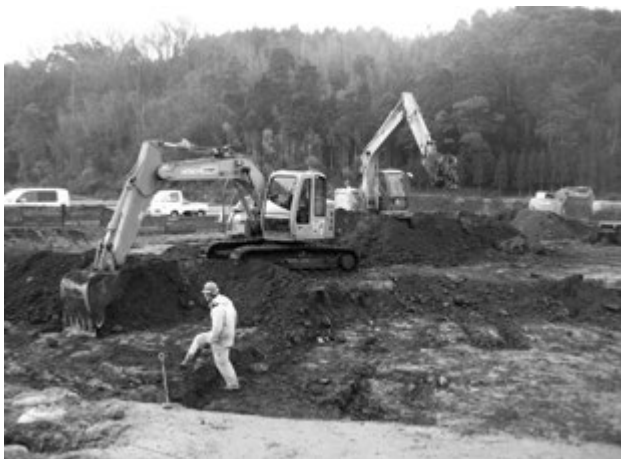
文中写真12 2区重機表土剥ぎ作業風景
