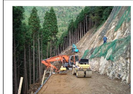
【林道の整備】 宝仏山及び窓山周辺の森林整備を進めるため林道を開設している。完成した林道は、森林に親しむ道としても広く利用されている。 (日野町金持)
