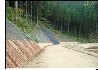
【公共事業での木材利用】 木材の需要拡大のため、行政が率先して木材を使う工夫を行っている。林道では法面の草抑えとして利用している。 (日南町上萩山林道窓山線。左は(株)オロチが排出する剥き芯を利用。)
