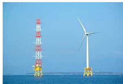
運転を開始した洋上風車 (左は既に観測中の洋上風況観測タワー)
