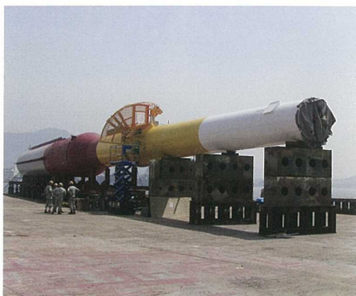
4. 浮体部の下部にコンクリート、上部に鋼をハイブリットしたスパー(円筒)に、白いタワー部を連結します。
