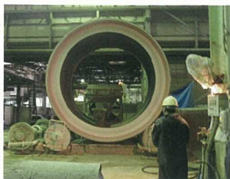
1. 円筒形の型枠を高速回転して、コンクリートを流し込みます。
