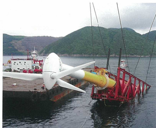
6. 柵島の設置海域付近で建て起こします。架台ごと徐々に沈めていくと、浮体が自然に浮き上がります。
