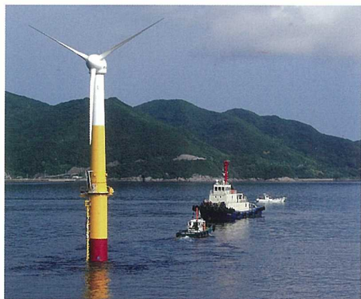
7. 設置海域まで曳航し、3本の係留チェーンとつないで設置完了です。
