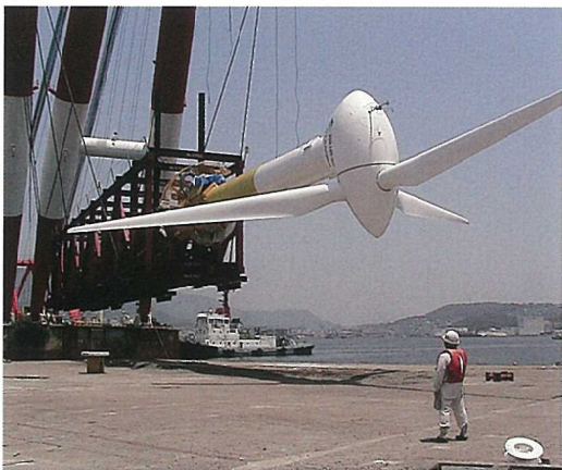
5. 風車を取り付けた後、大型の起重機船で慎重に吊り上げて、五島に向けて搬出します。
