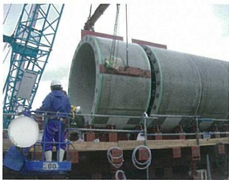
2. 下部浮体部は10個のコンクリート製リングをつなぎ合わせます。
