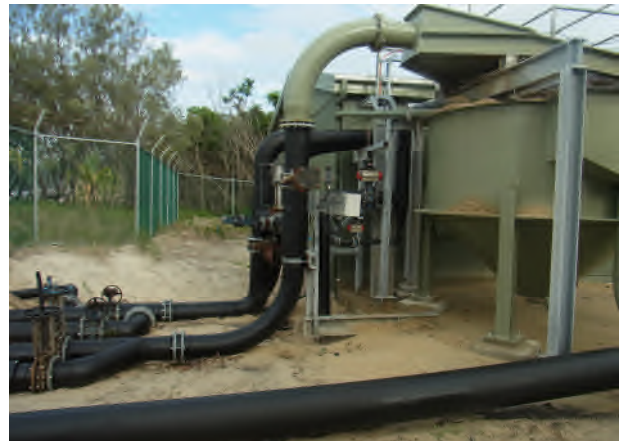
写真-11 ホッパー式異物除去装置 d
