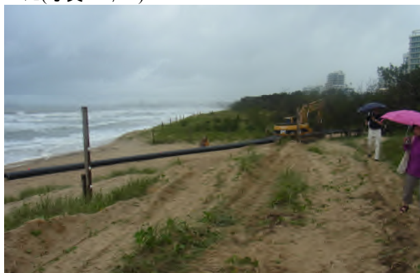
写真-23 パイプライン建設中 a
