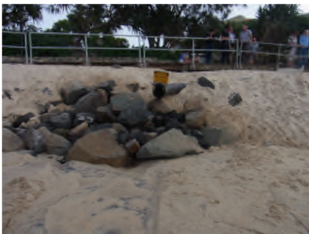
写真-1 砂排出口付近の近景 (上側は通路)
