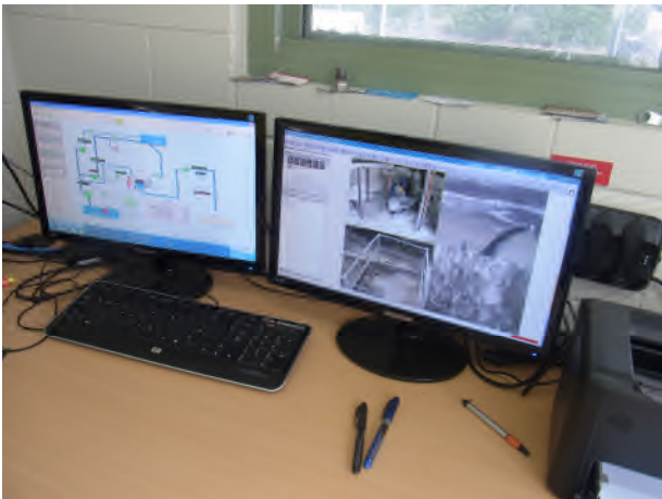
写真-14 システム制御室内のモニター全景
