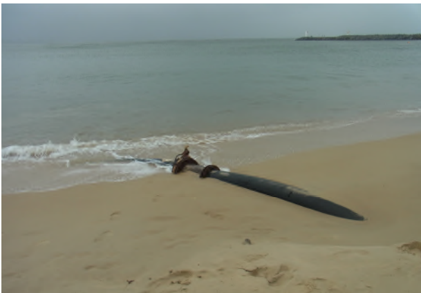
写真-28 Mooloolaba Beach 地下のパイプライン
