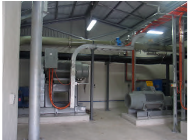
写真-17 ポンプ室内部
