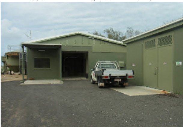
写真-16 ポンプ室全景
