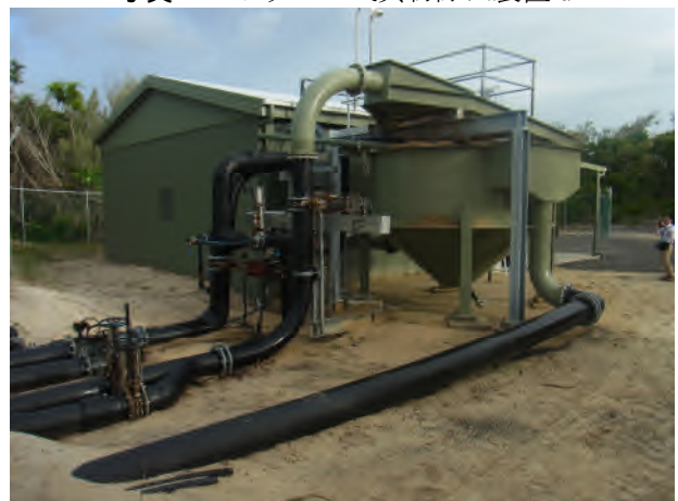
写真-12 ホッパー式異物除去装置・ポンプ室全景
