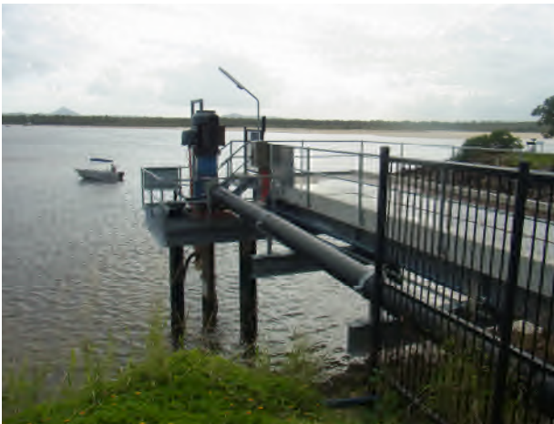
写真-6 給水ポンプ全景
