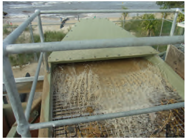
写真-9 ホッパー式異物除去装置 b
