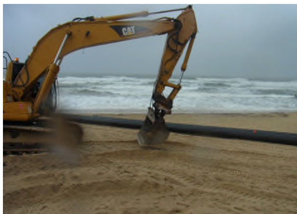
写真-24 パイプライン建設中 b
