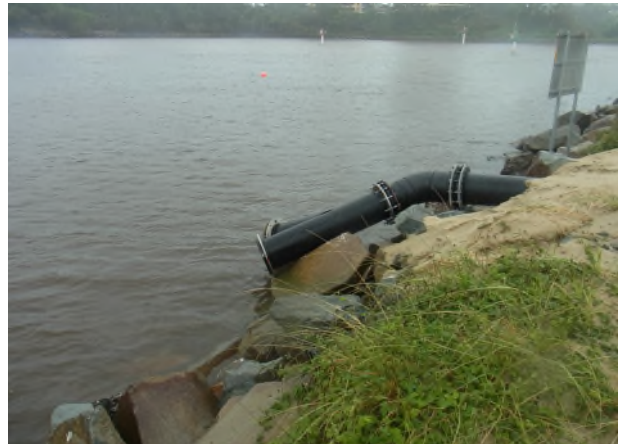
写真-30 Mooloolaba River とパイプライン接続部
