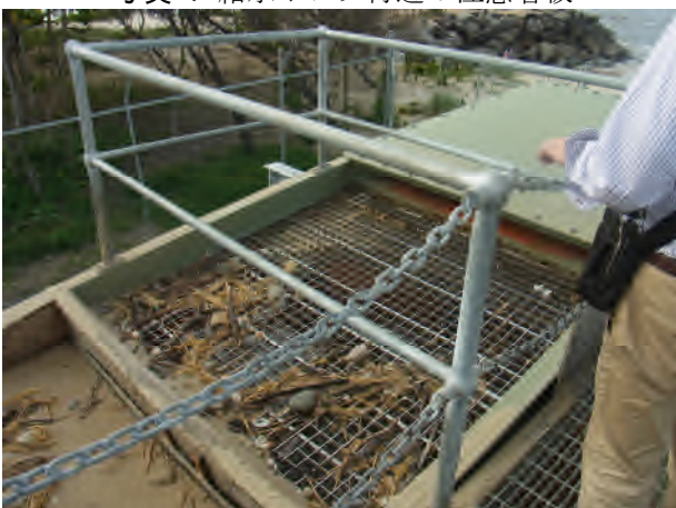
写真-8 ホッパー式異物除去装置 a
