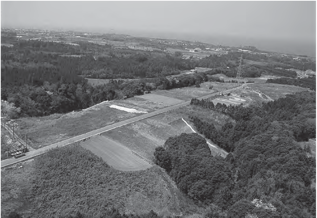
1 . 調査地遠景（調査前，南東から）
