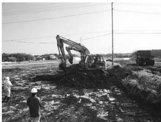
文中写真1 3区重機表土剥ぎ作業風景
