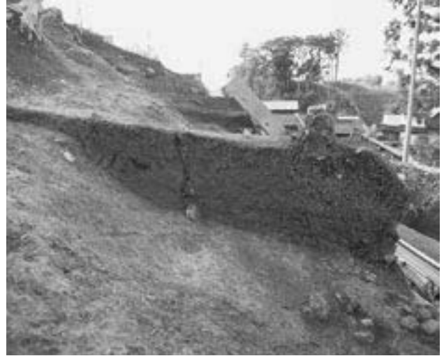
2. 段状遺構2 盛土土層断面 (東から)
