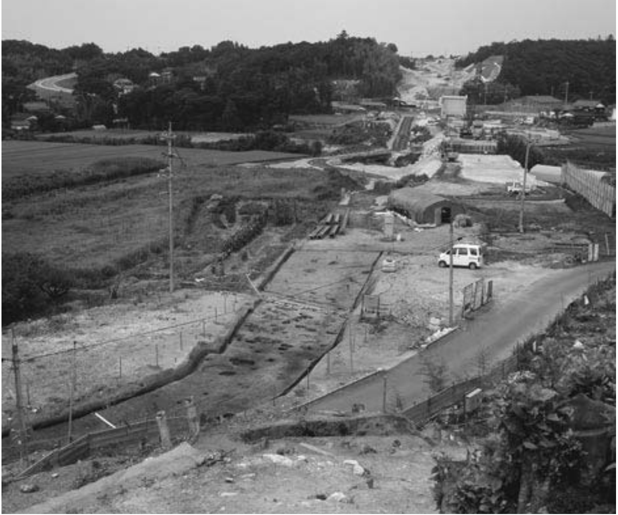
1 .8区完掘状況（南から）
