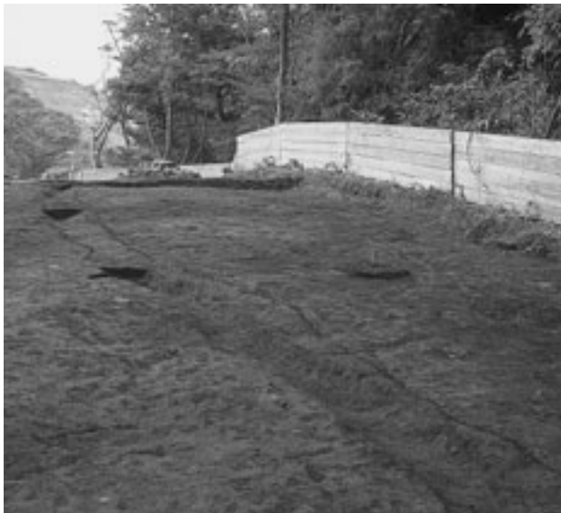
3. 溝1 (新)完掘状況(南西から)
