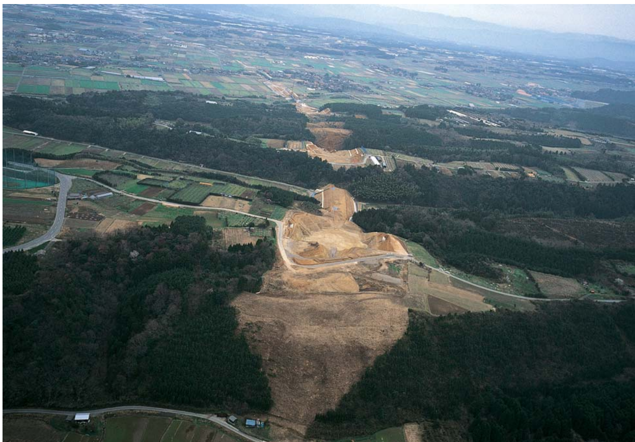
1 調査区遠景（調査前・西から）
