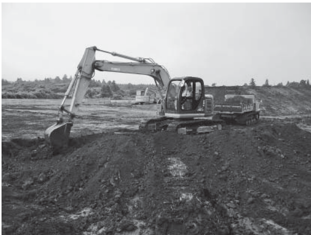
写真1 豊成上神原遺跡表土剥ぎ風景
