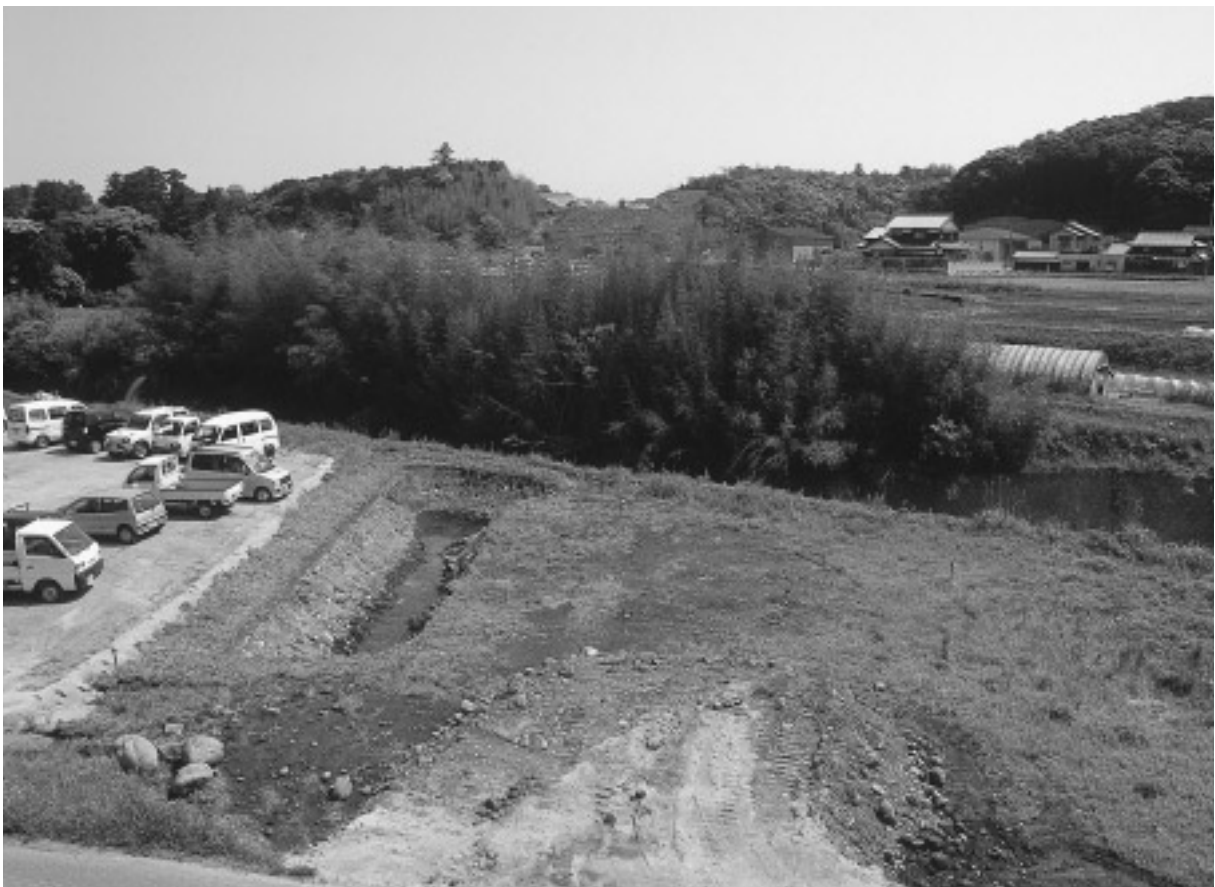
2 1区完掘状況（南西から）
