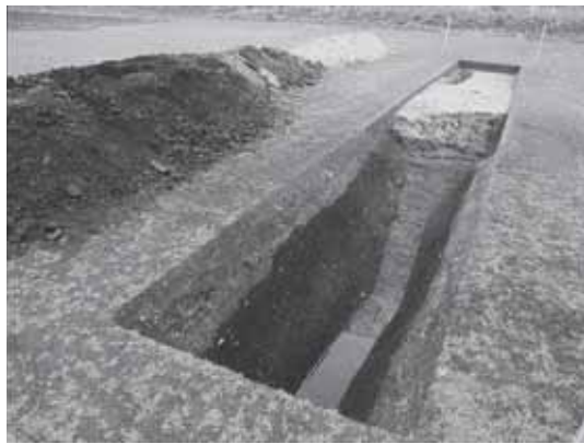
3 Tr.17完掘状況(南西から)
