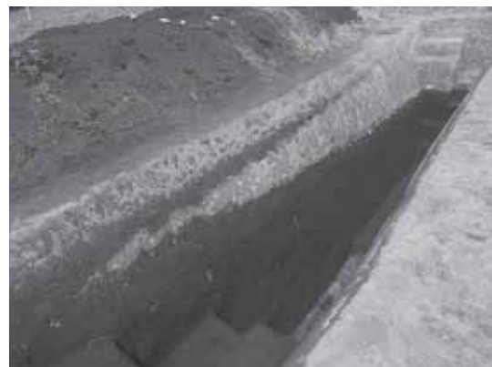
8 Tr. 9 完掘状況(南西から)
