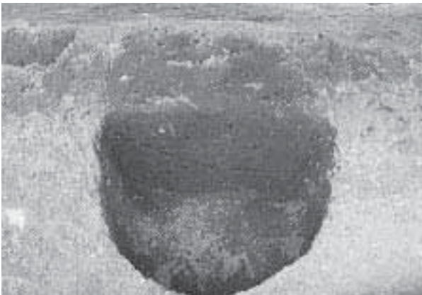
5 掘立柱建物1 P13土層断面(東から)
