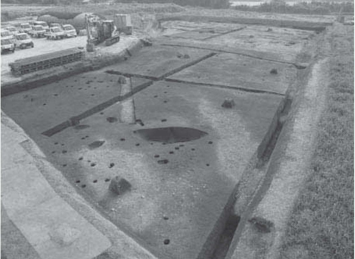
1 B区第2遺構面完掘状況1(北東から)
