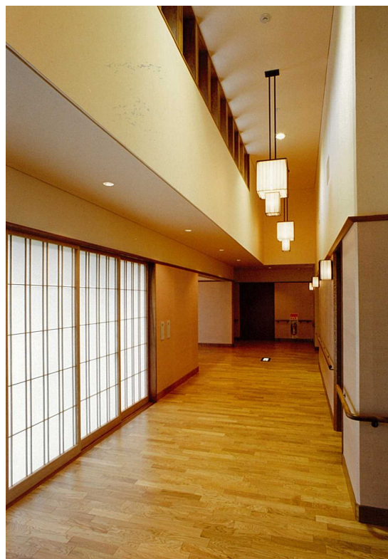
知事公邸 廊下の床に県産ナラ材フローリングを、その他各居室等の床に県産松、杉のフローリングも使用。
