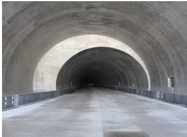
今後は、照明や消火施設等の設備工事とともに、正面衝突等による重大事故を防ぐため、中央部にガードレールを設置していきます。
