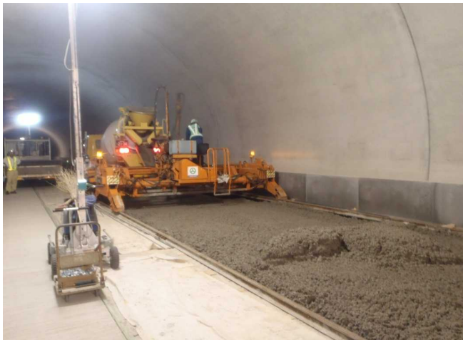
コンクリート舗装の施工状況です。ミキサー車でトンネル内まで運搬した生コンクリートをコンクリートフィニッシャーで敷き均しました。
