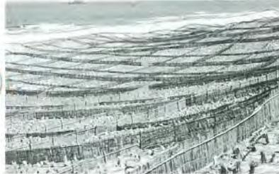
飛砂害を防止するため、クロマツ等を植栽して海岸林を造成
