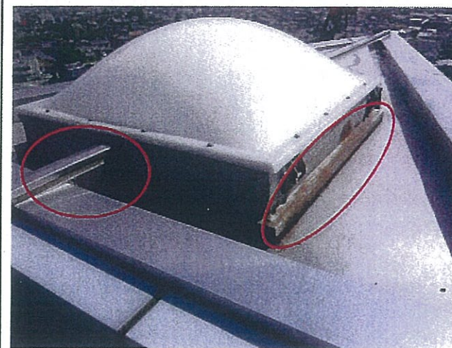
写真2 撮影箇所: 光塔屋上 トップライトと防水立上り 取合
