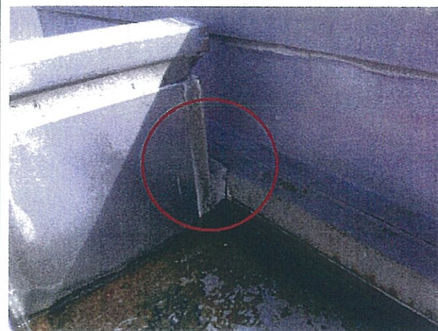
写真3 撮影箇所: 光塔屋上 トップライトと防水立上り 取合 シーリング撤去
