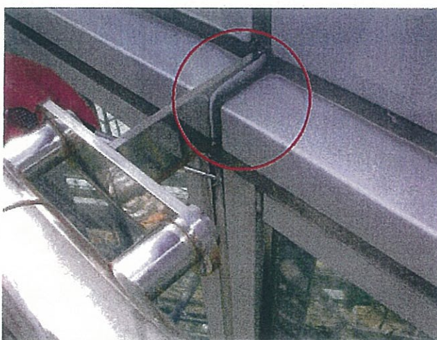
写真3 撮影箇所: 光塔屋上 水切とパイプ支持金物 取合い
