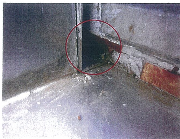
写真3 撮影箇所: 光塔屋上 トップライトと防水立上り 取合 シーリング撤去
