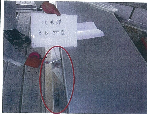
写真2 撮影箇所: 円筒形外壁パネルと防水 取合
