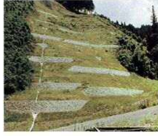
崩壊地の復旧を図るため、山腹工を実施し森林の機能回復を図った。 (昭和49年)
