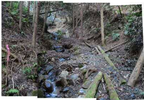
平成21年8月の豪雨により、著しい溪岸浸食が発生し、下流に土砂が流出した。
