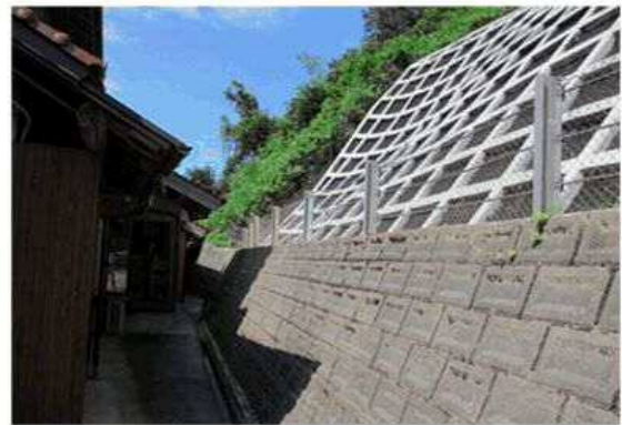
山腹崩壊箇所の復旧により、山腹斜面の安定が図られ森林が回復し安定した。
