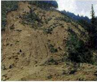
豪雨により山腹崩壊が発生し、森林が著しく荒廃した。 (昭和47年)
