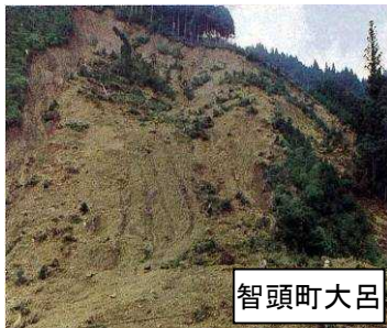
崩壊状況（S40年代）
