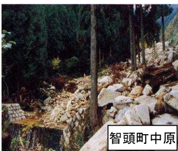
崩壊状況（S50年代）
