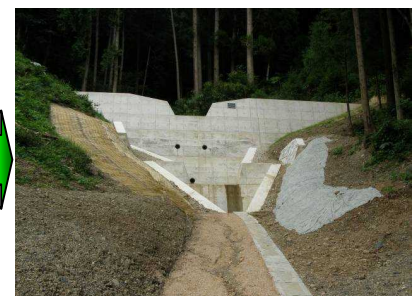
復旧完了（H20.9）
