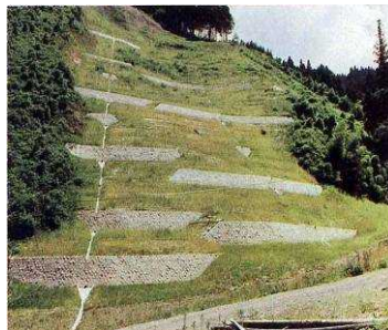
工事完成後（S40年代）
