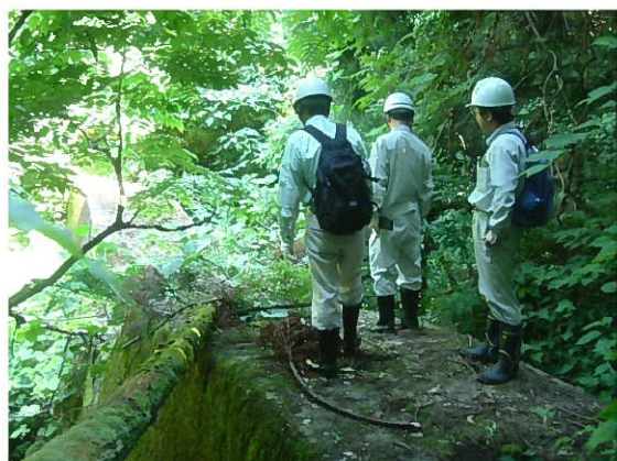
施設点検の様子
