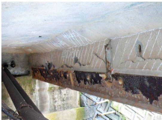
主桁の損傷
