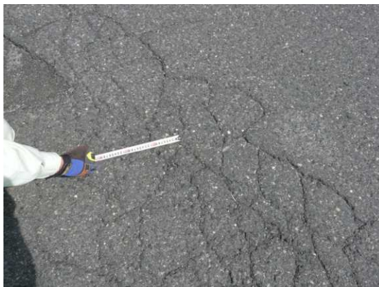
舗装のひびわれ
