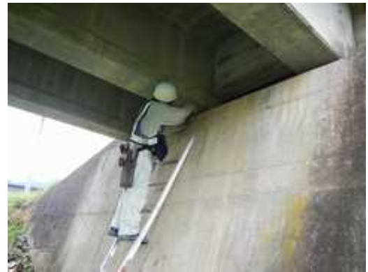
＜梯子等による点検実施状況＞
