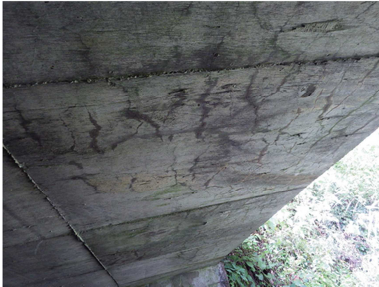
床版下面のひびわれ状況
