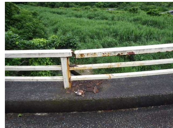
防護柵の破断
