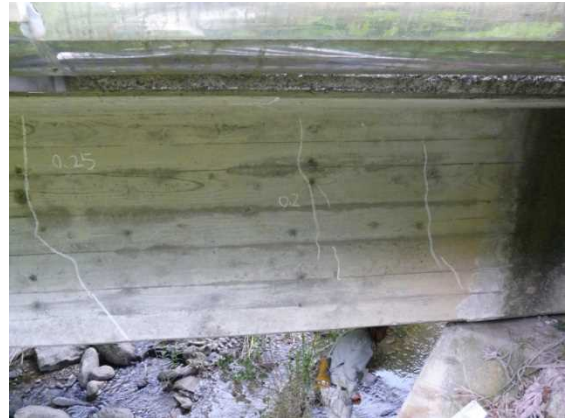
主桁のひびわれ状況
