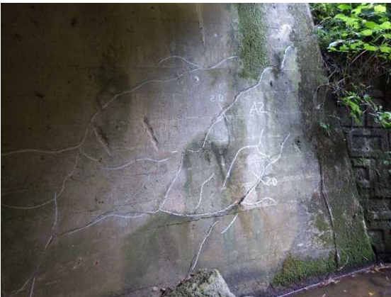
橋台のひびわれ
