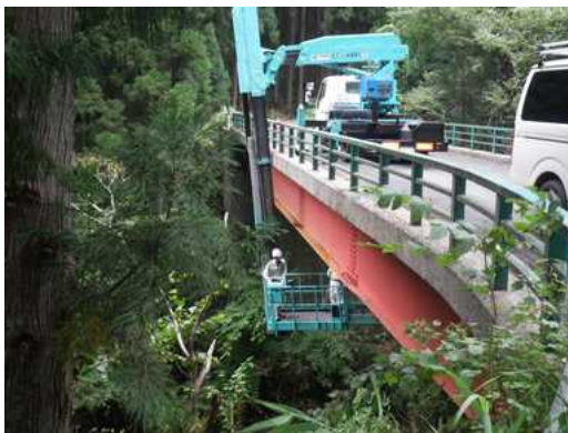
＜橋りょう点検車による点検実施状況＞
