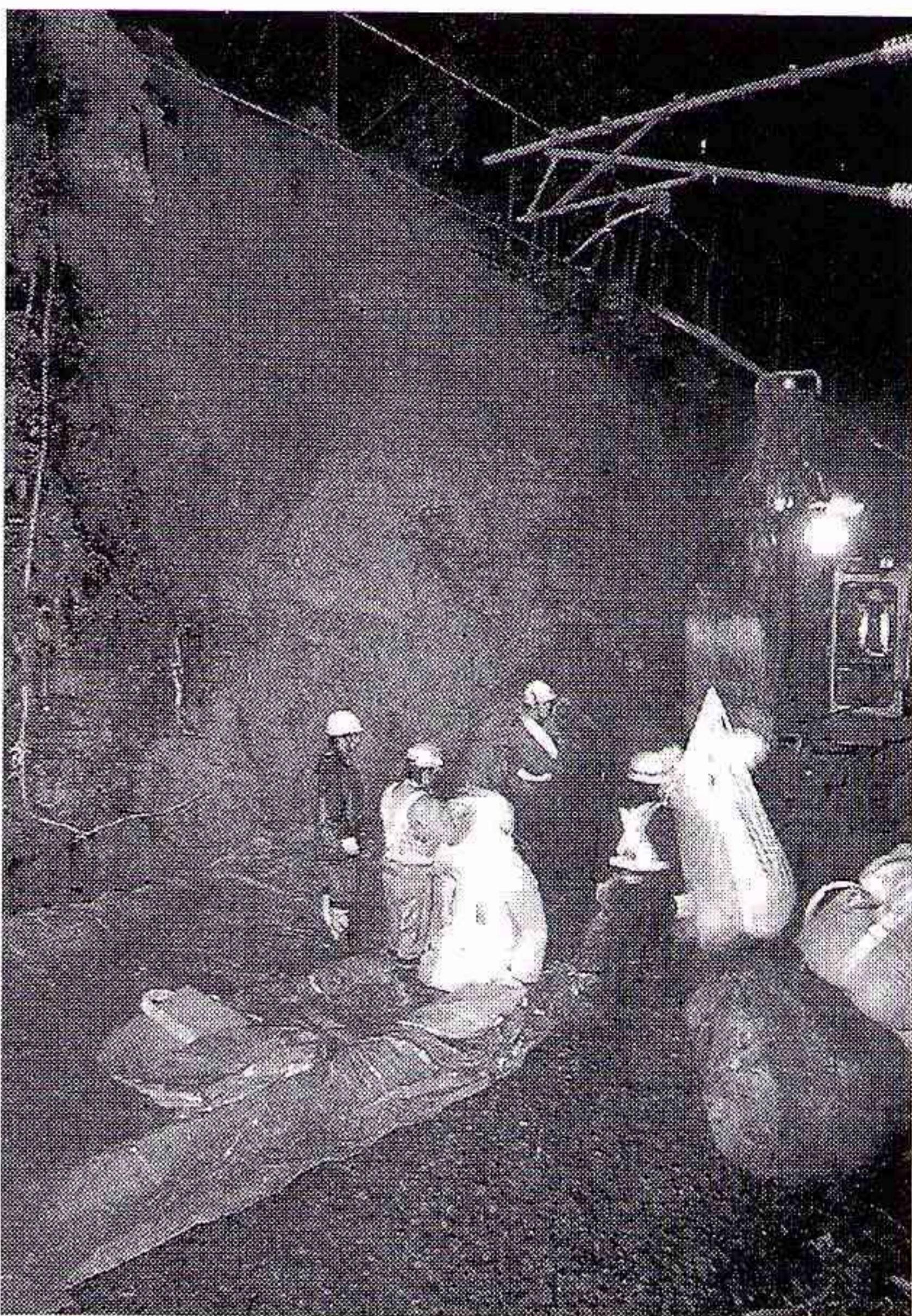
山が崩れ落ち、線路を埋めた土砂を撤去する作業員ら＝28日午後10時45分ごろ、鳥取県日野町根妻、J R伯備線根妻トンネル付近
