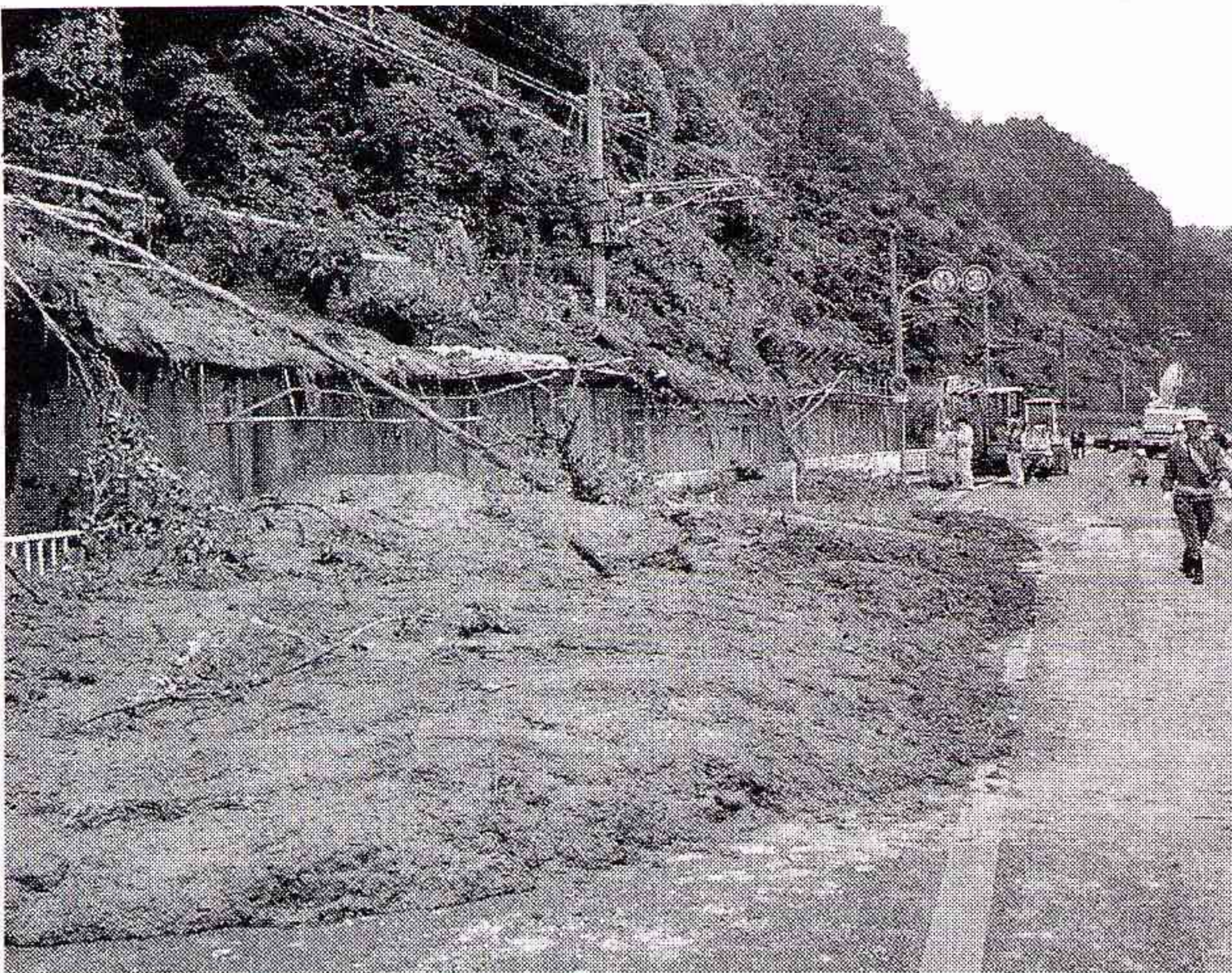
余震による土砂崩れで寸断された国道181号。左上は不通になっているJR伯備線(8日午後、鳥取県日野町)
