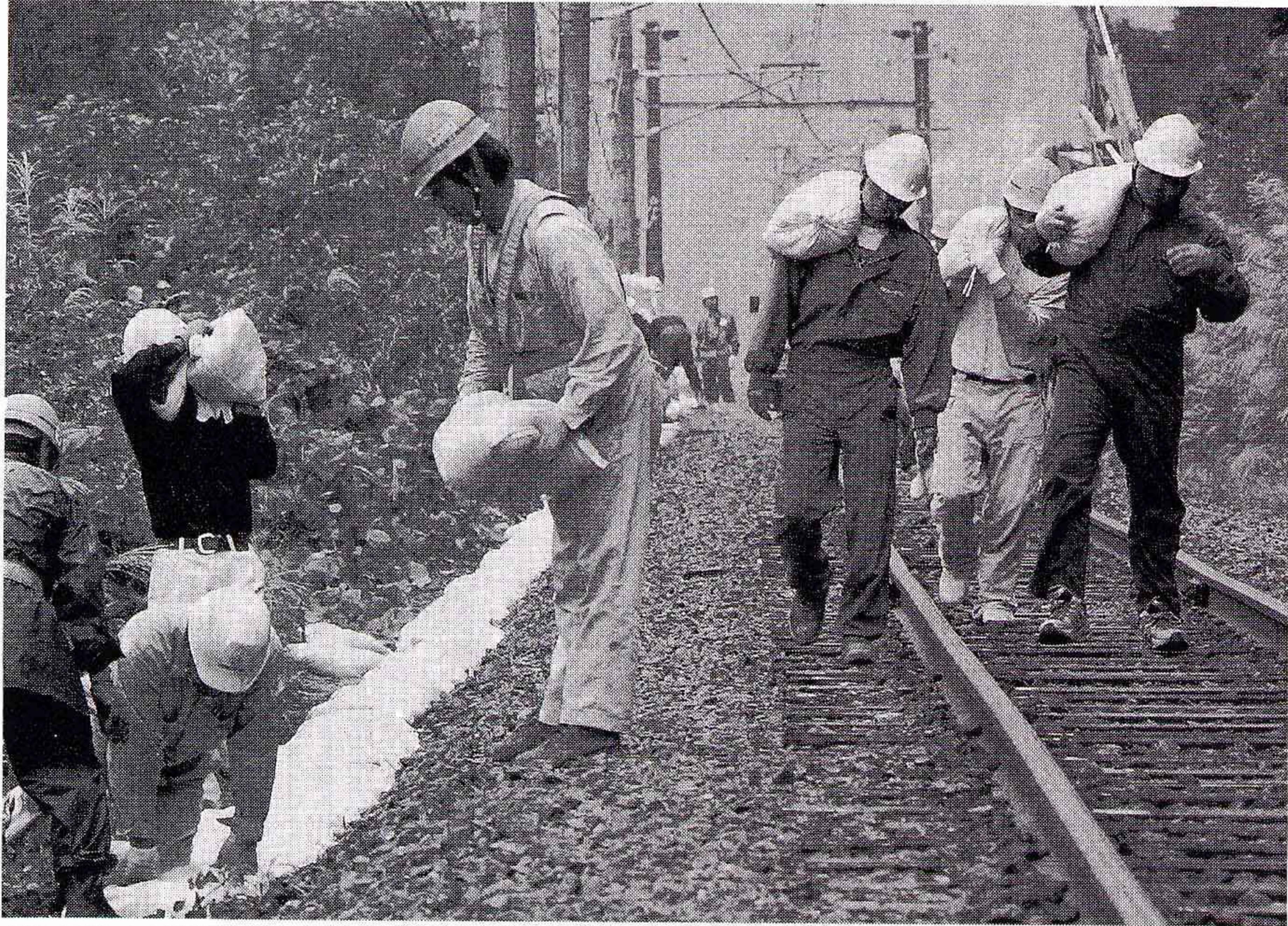
地震で緩んだ線路の地盤を土のうで補強する作業員＝8日午前9時25分、鳥取県日野町のJR伯備線
