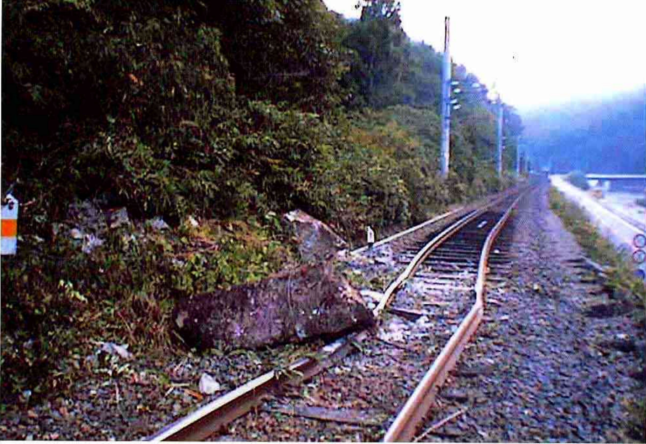
10月6日 伯備線97K690m落石災害
