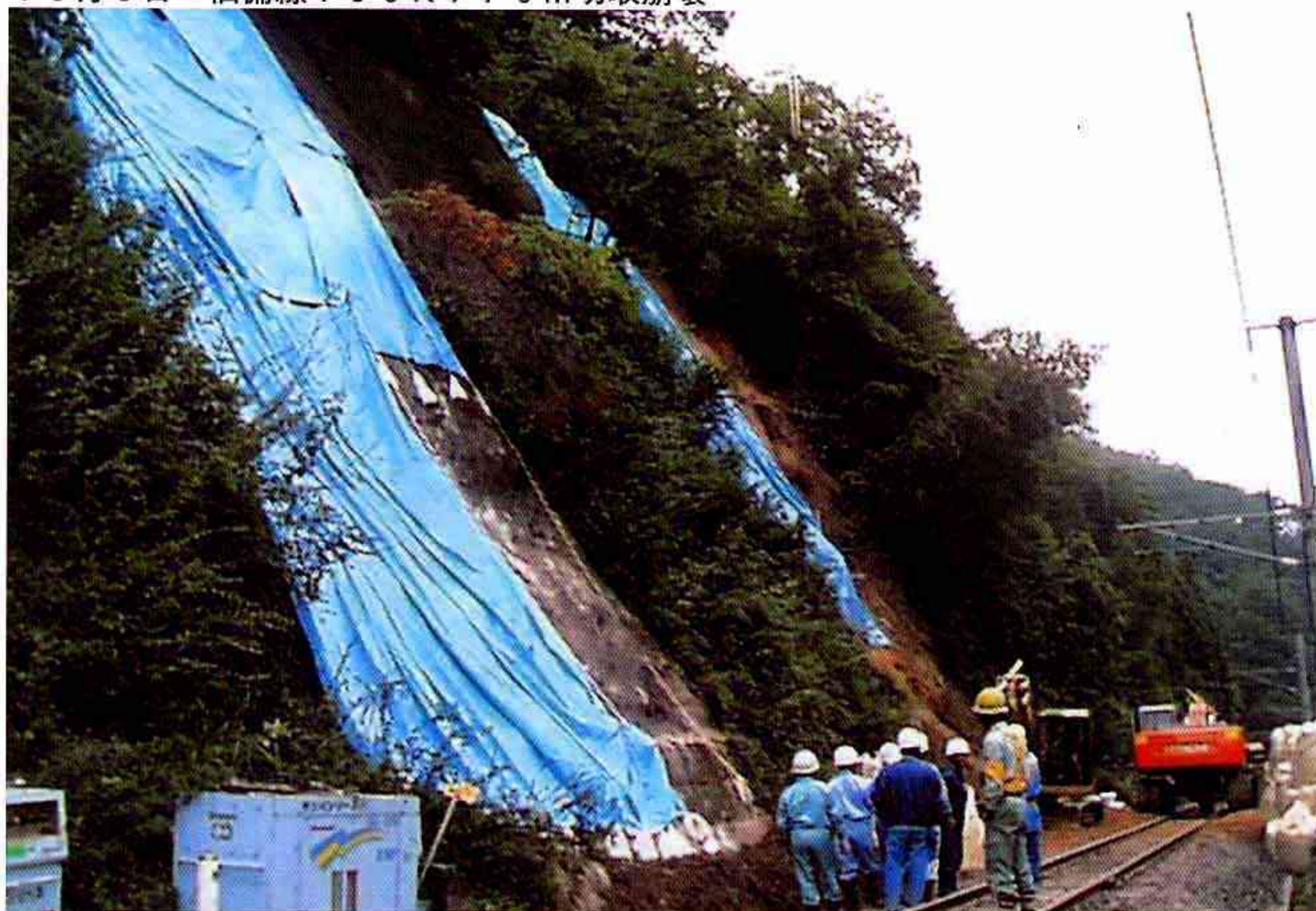
10月6日 伯備線106K770m切取崩壊
