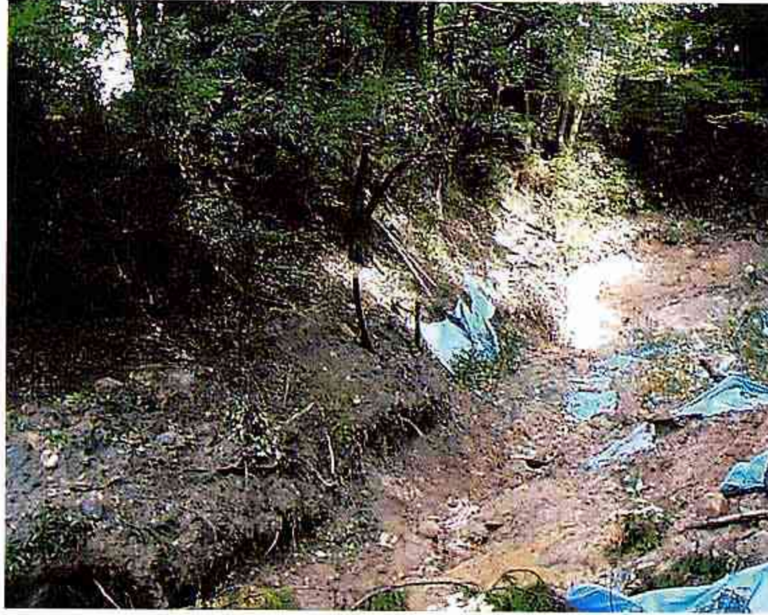
10月6日 伯備線94K750m切取崩壊
