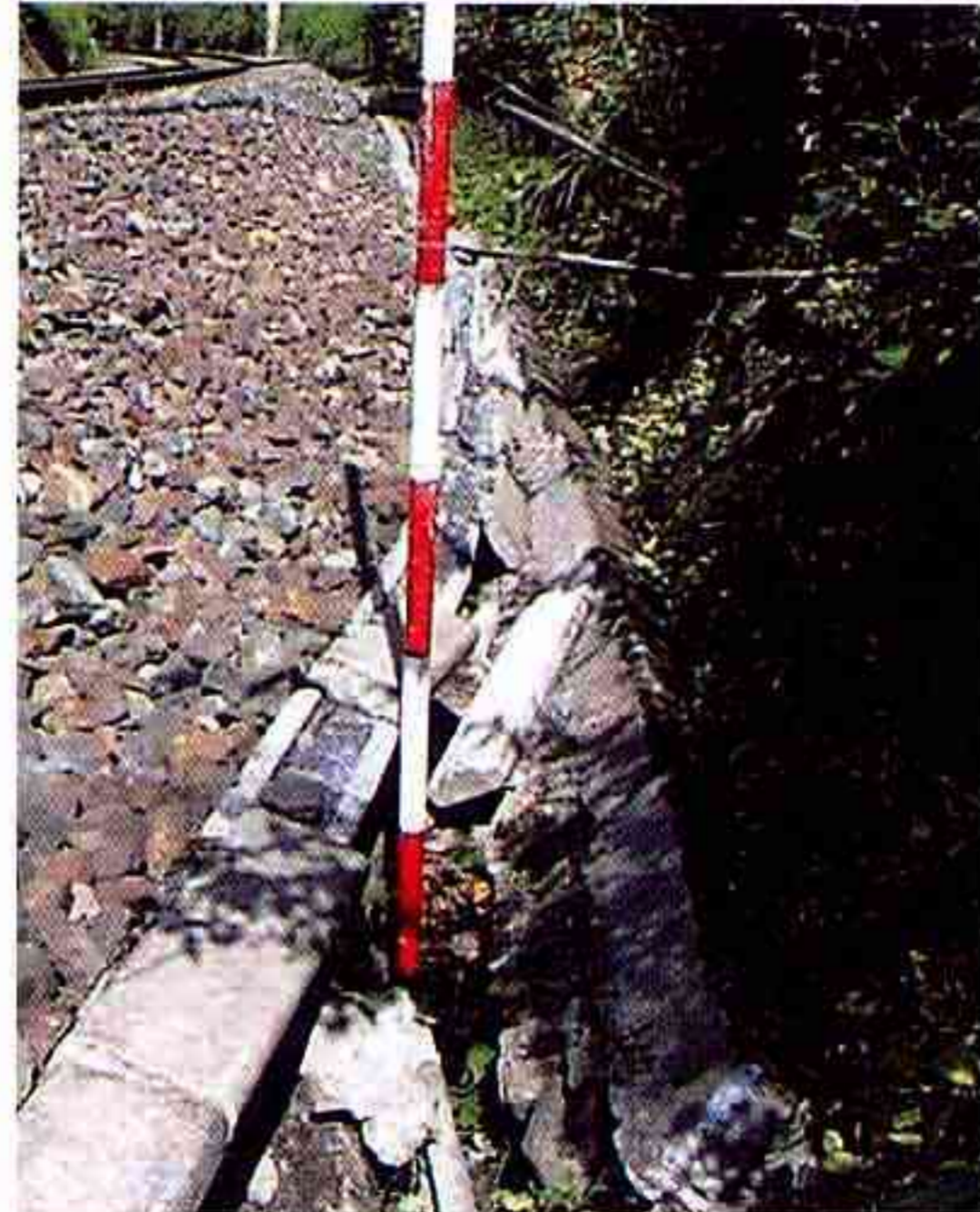
▼10月6日 伯備線109K100mパラスト止変状
