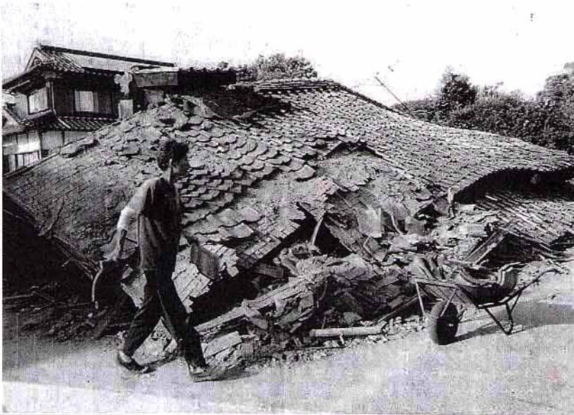
鳥取県西部を襲った強い地震で倒壊した鳥取県西部市の民家の6日午後3時30分
