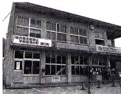
地震の被害で取り壊される溝口町役場
