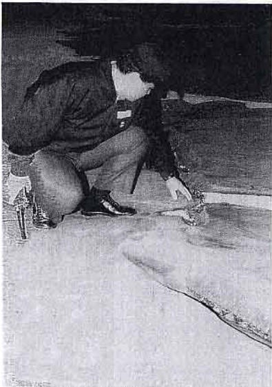
液状化して砂が吹き出した米子空港の滑走路＝6日午後6時ごろ
