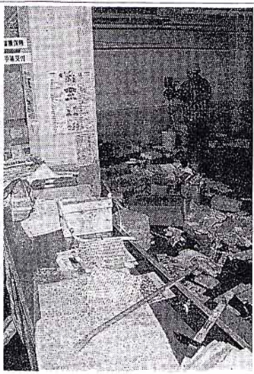
地震で被害を受け、取り壊される溝口町役場。庁内は書類などが散乱したままになっている。
