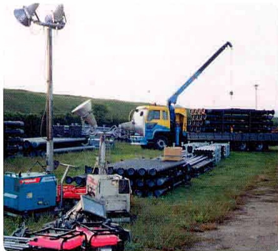
仮設資材置場に搬入された資材(車尾水源地内)
