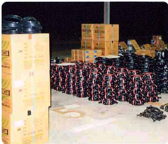
その日のうちに運び込まれた資材(水道局車庫)
