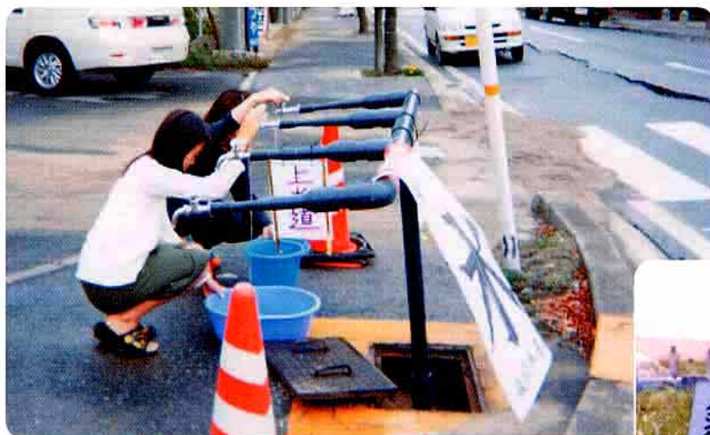
消火栓に設置した応急給水栓から実際に給水しているところ
