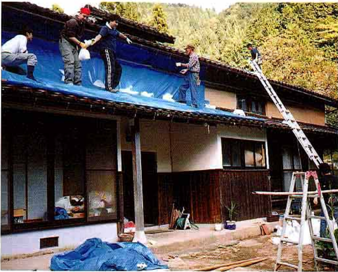
ボランティアによるブルーシート張り
