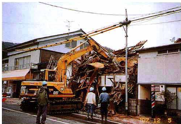
家屋の解体も公費で行った
