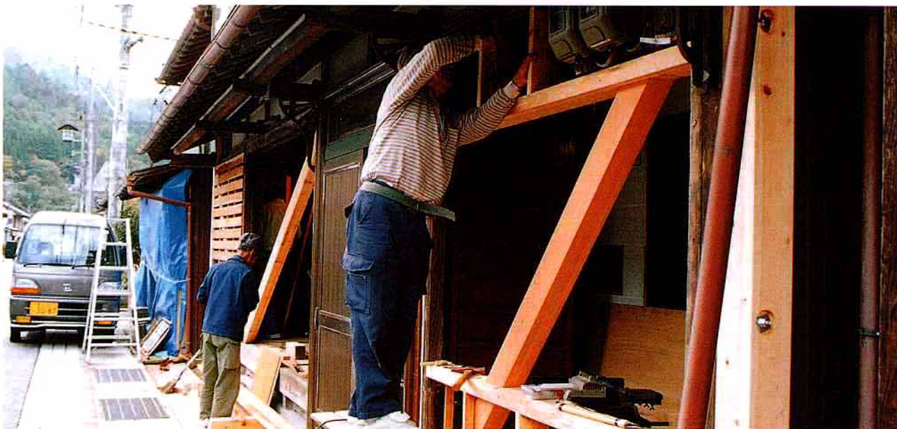
町は住宅復興補助金として住宅の新築に300万円、修繕に150万円、また石垣や擁壁の補修、井戸の改修にも補助している
