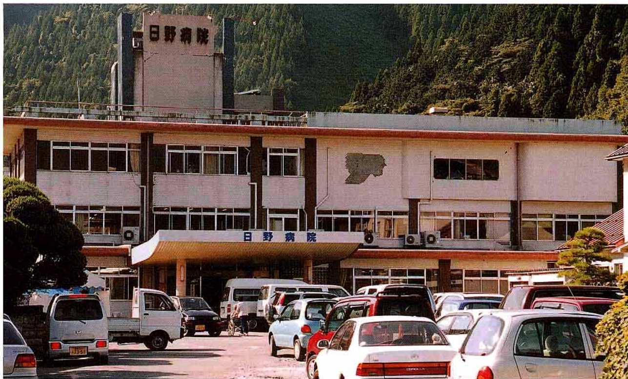
老朽化が進み、新築移転を進めていた矢先の日野病院
