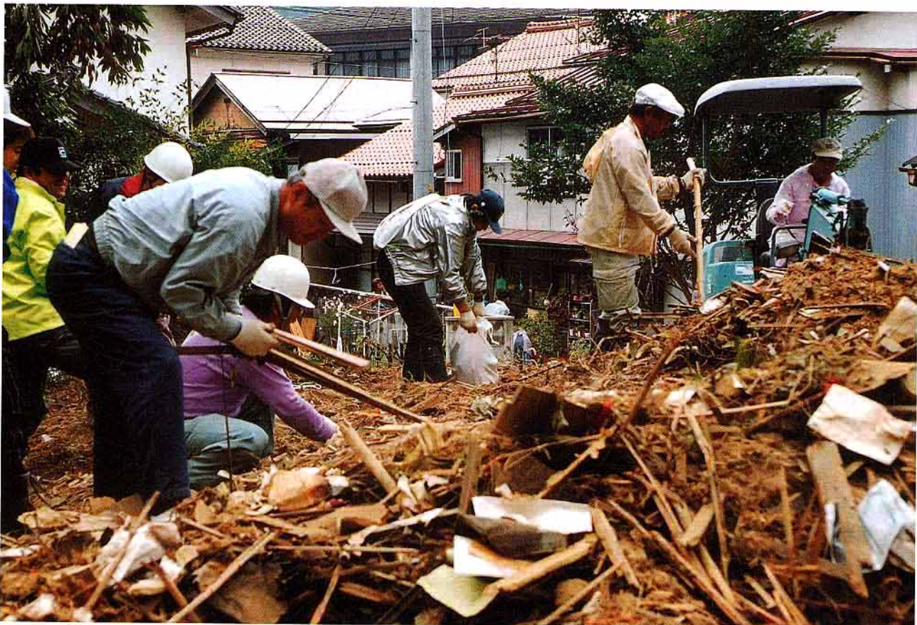
ガレキの撤去や屋根のブルーシート張りなど、ボランティア活動は高齢化の進んだまちにとって復興の大きな力となった（根雨地区）
