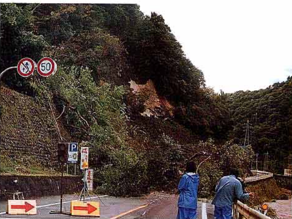
国道の数か所に土砂が流出し、道をふさいだ（国道180号・本郷地内）
