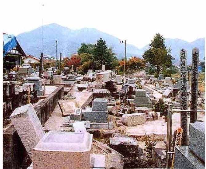
墓石の倒壊も激しい（黒坂地内）
