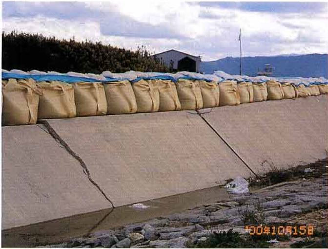
写真20 飯梨川河口。堤防は1m以上沈下した。堤防の周囲では噴砂が多く見られた。
