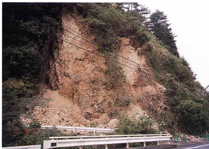
写真 33 花崗岩斜面の崩壊。西伯町大木屋。
