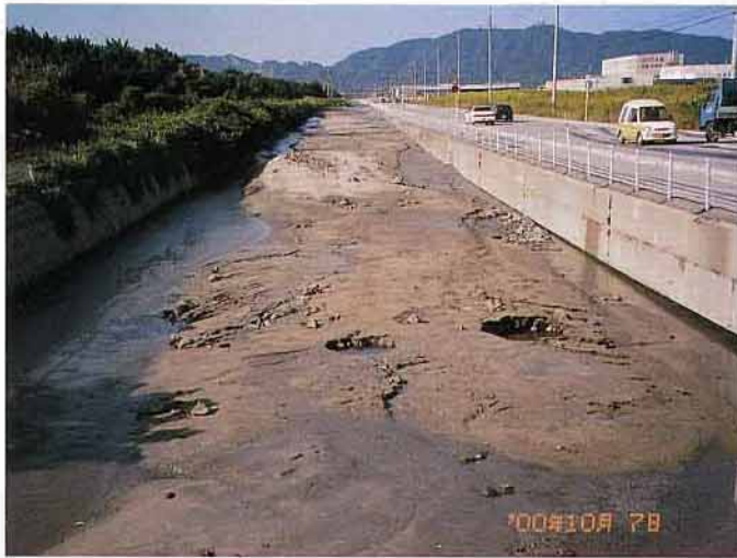
写真3 竹内工業団地。地震発生当日の高松川川底、厚さ50cmで碎石を敷いた川底は全体的に隆起しており、砂の中に散在する角礫は川底の敷石である。
