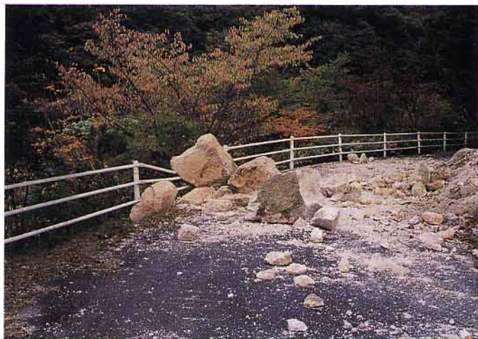
写真 32 花崗岩ブロックの落石。日南湖周回道路。
