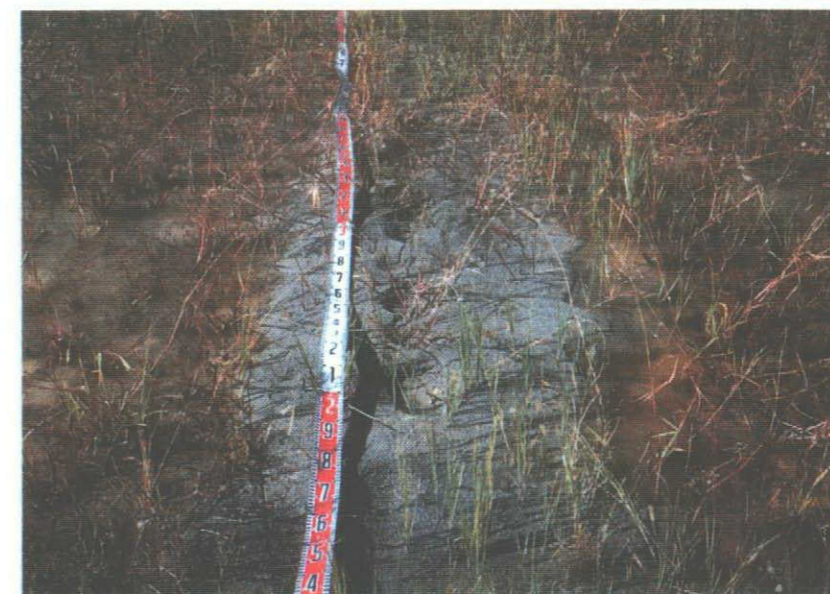
写真-9：宅地に生じたクラックと噴砂跡。
