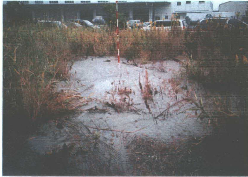
写真-13 填砂の状況
