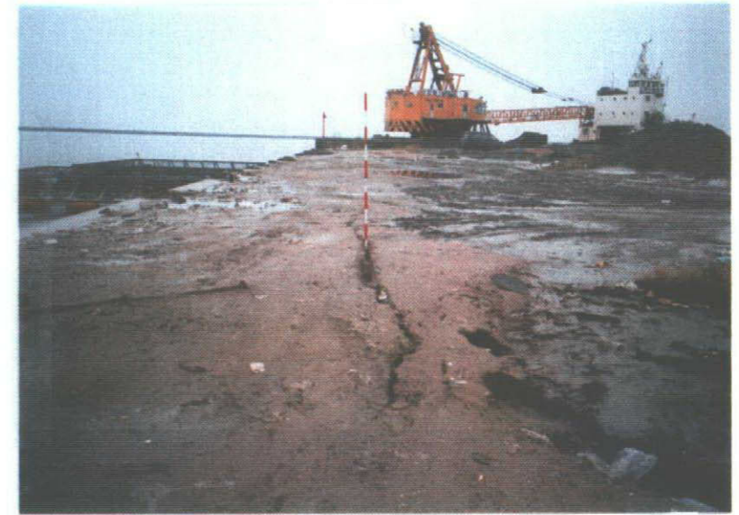
写真-3 護岸と平行にクラック噴砂が見られる
