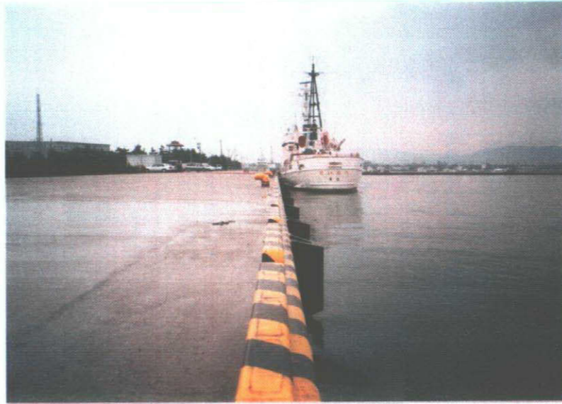
写真-2 護岸の変状は認められない
