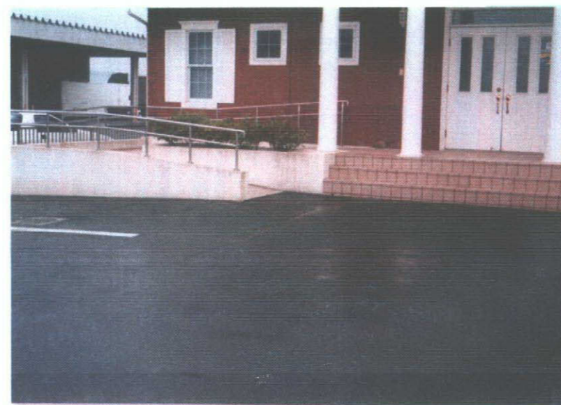
写真-17 外部の変状が認められない 敷地と建物
