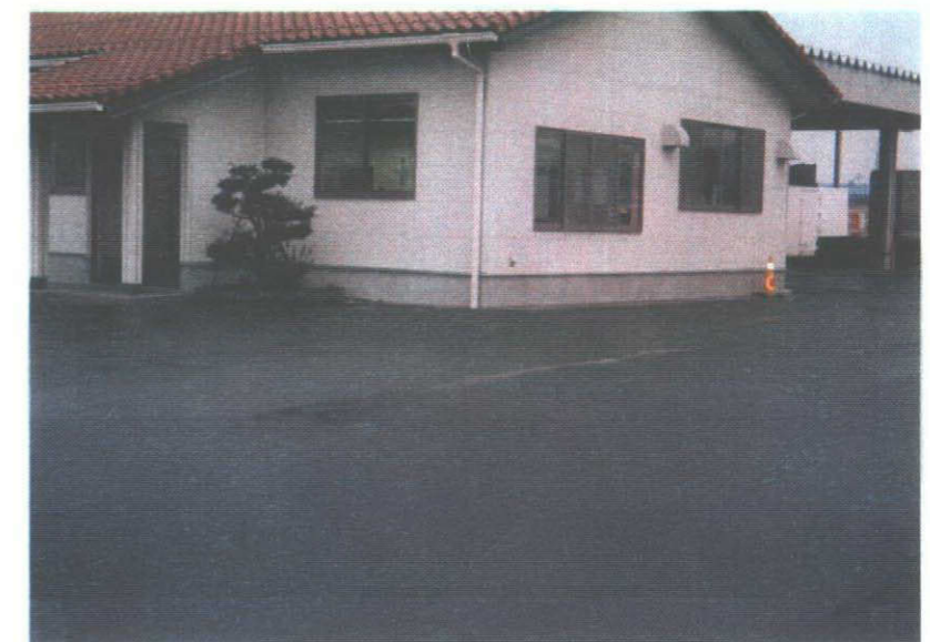
写真-18 外部の変状が認められない 敷地と建物
