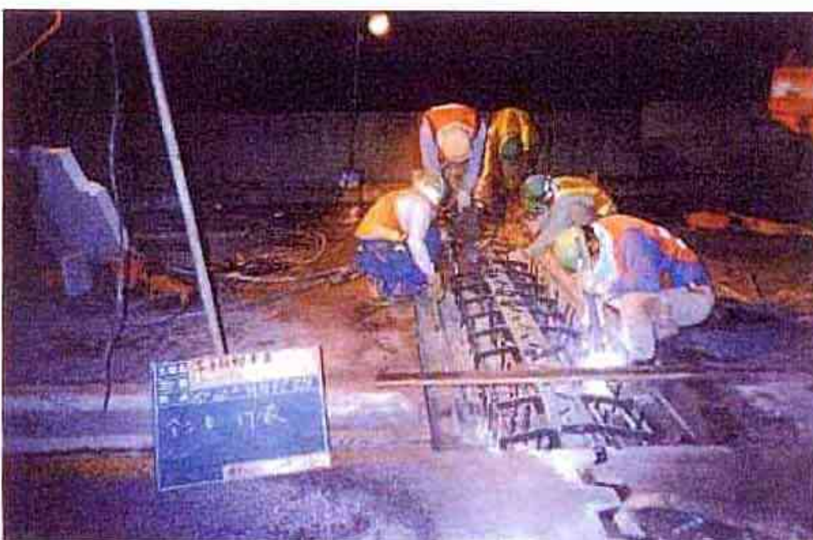
別所川橋 伸縮装置取替
