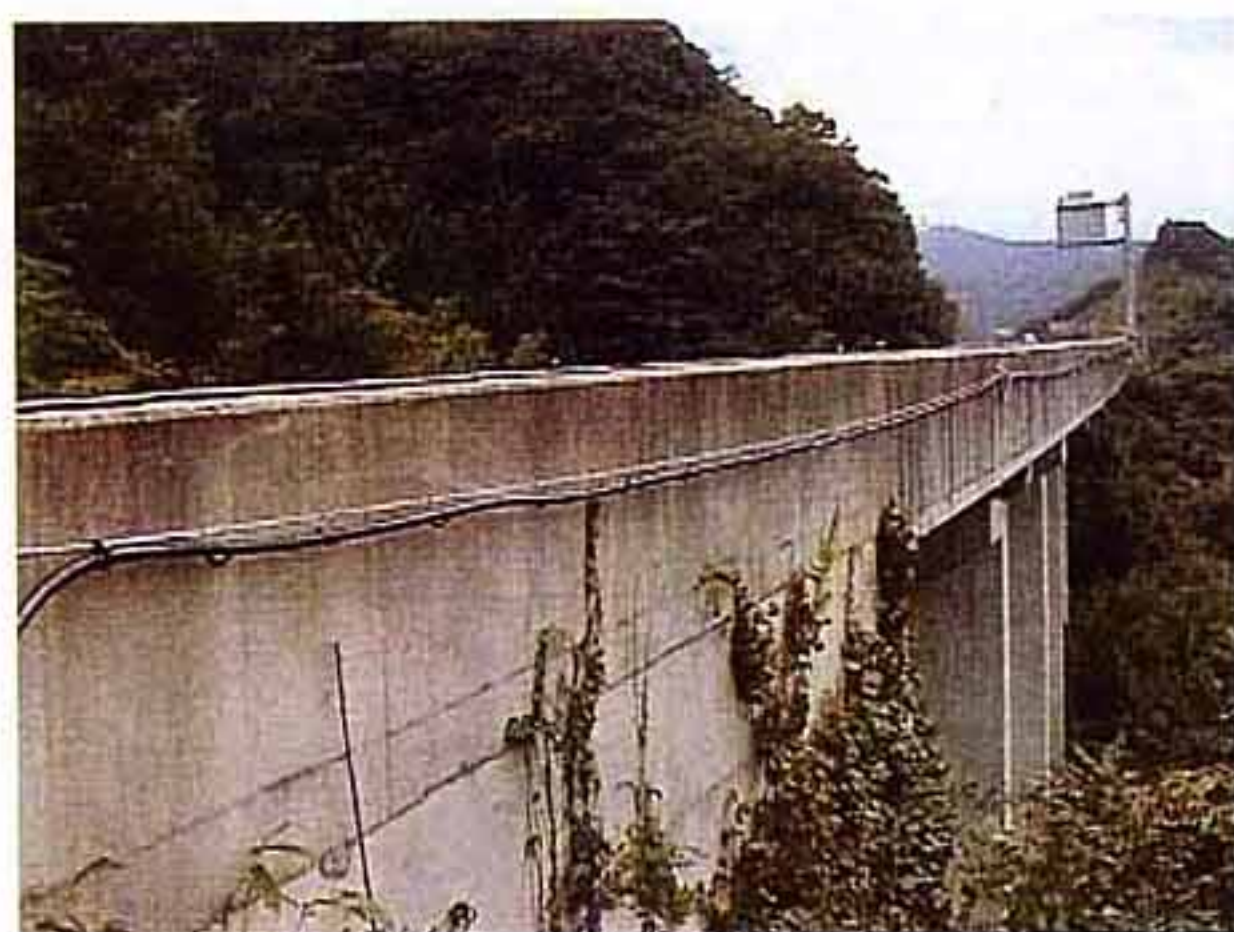
佐川橋 通信幹線応急復旧 複合ケーブル敷設
