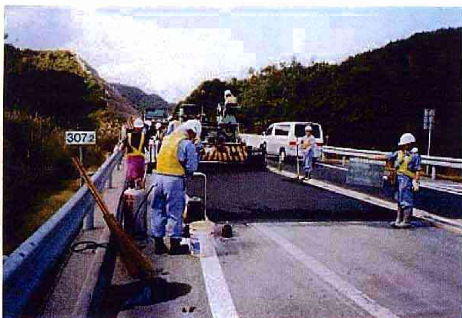
安来道路 段差修正
