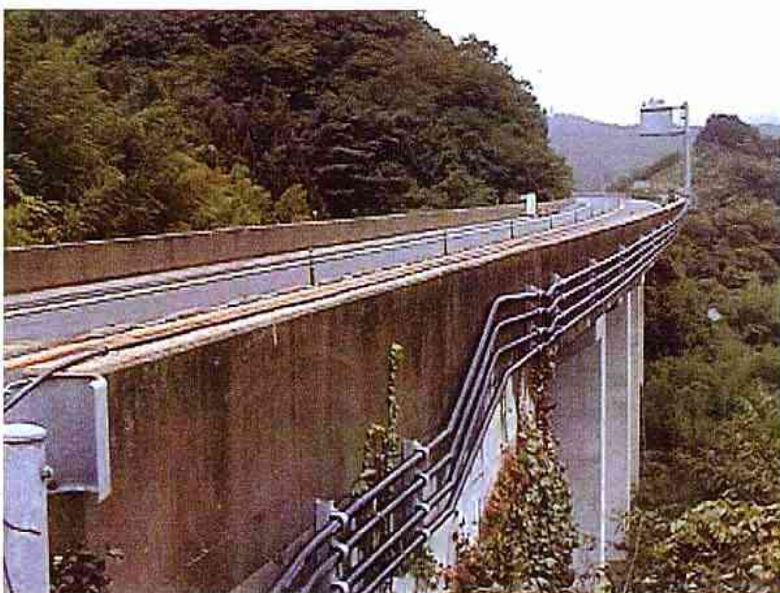
佐川橋 通信ケーブル復旧状況
