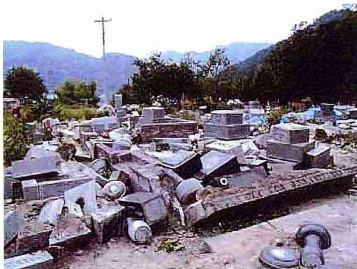
⑮墓石の転倒（日野町） 8)
