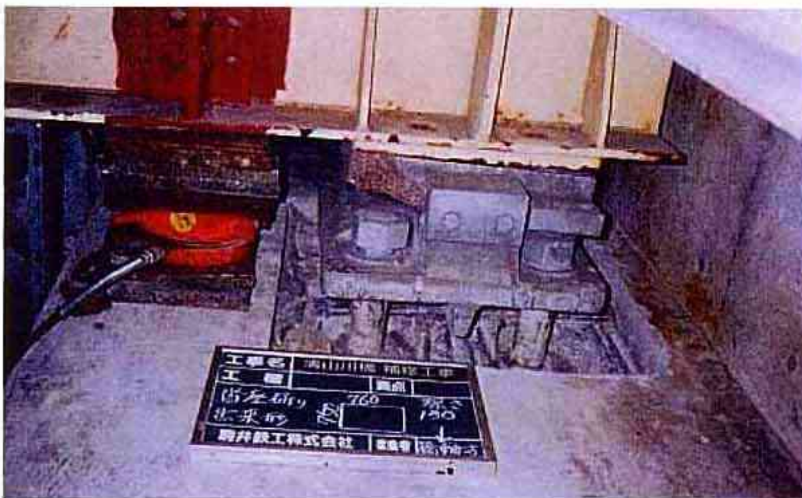
清山川橋 沓座ハツリ完了
