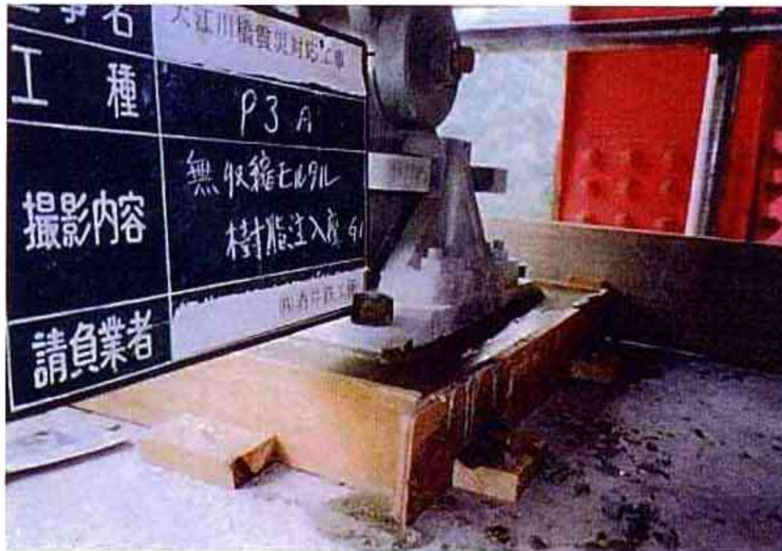
大江川橋 沓座モルタル補修
