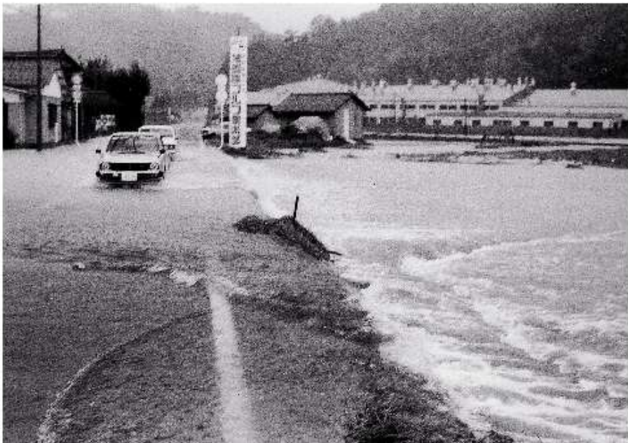
②主要地方道鳥取鹿野倉吉線冠水状況（写真手前が湖山川）
