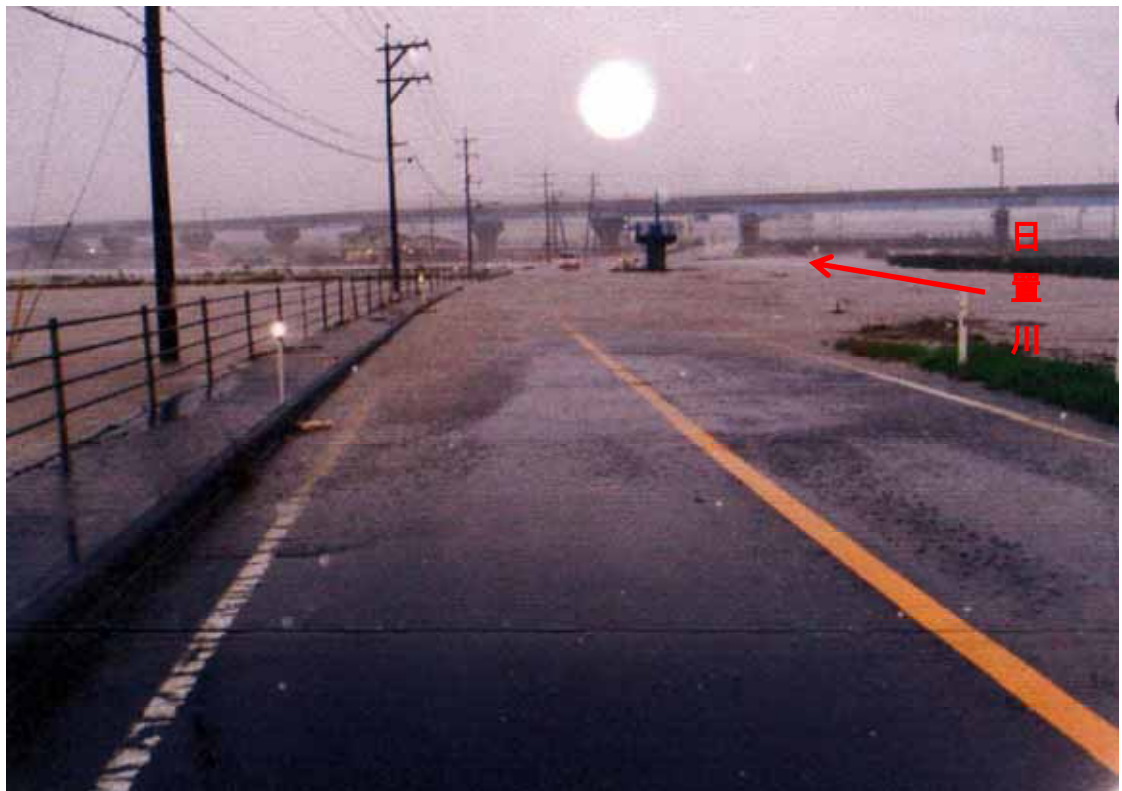
被害状況写真 1-2 県道依原青谷線冠水状況(H16.10 台風 23 号)
