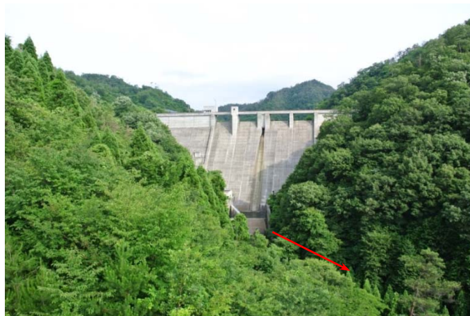
朝鍋ダム 下流側より
