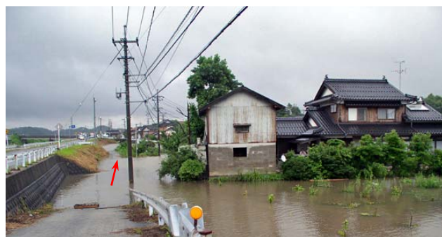
平成 18 年 7 月洪水による 内水被害状況 (米子市青木)
